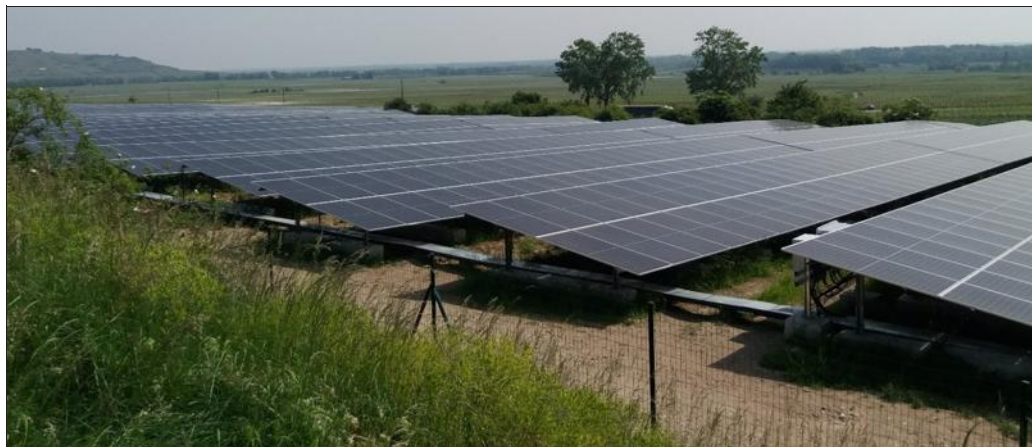
Le chantier de construction du parc photovoltaïque de Katzenthal s'est achevé en mai 2023. Le coût du projet s'élève à 2 millions d'euros. Photo JAC/Thomas JOCHUM
