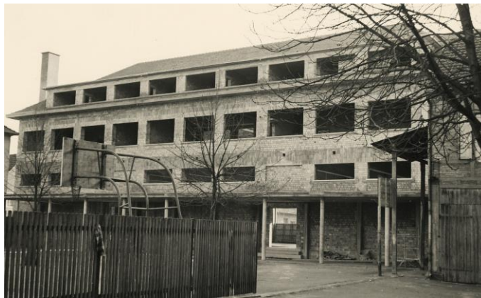
Bâtiment Sainte- Marie, la salle des Fêtes, en construction
