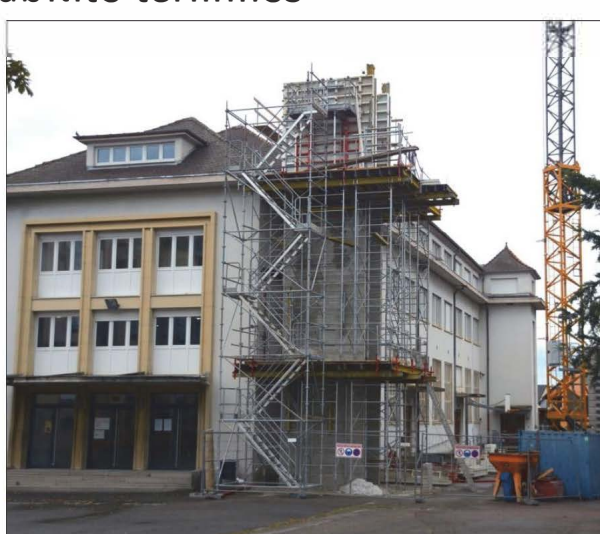
Le bâtiment Sainte-Marie a été complètement réhabilité. Désormais les étages supérieurs accueilleront uniquement l'internat. L'ascenseur extérieur destiné aux élèves à mobilité réduite est en cours d'achèvement.
